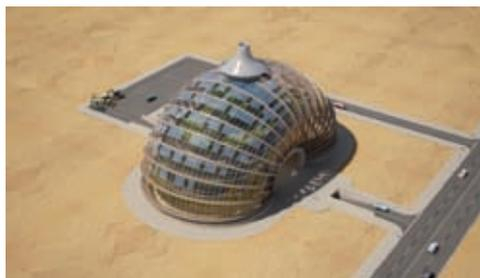
Cette coupole tubulaire est composée d'une structure en bois maintenue par un câblage d'acier complexe. Capable de flotter, souple et anti sismique, l'Ark est dotée d'une couverture en ETFE, un matériau innovant auto-nettoyant et recyclable, plus transparent, plus économique, plus léger et plus solide que le verre !
