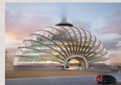
Sa forme favorise la formation d'un tourbillon à la surface extérieure du corps du bâtiment ; l'air généré par ce tourbillon y est récupéré par des générateurs à accumulation. En maintenant l'air chaud dans sa partie haute, le bâtiment accumule de la chaleur et la redistribue quand il le faut.
