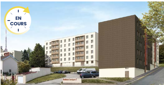
148 logements - LAMOIGNON - LE HAVRE
